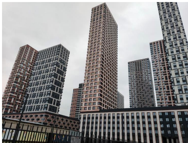
Рисунок 1 – Общий вид объекта обследования с облицовкой фасадов из тонких крупноформатных фиброцементных плит
